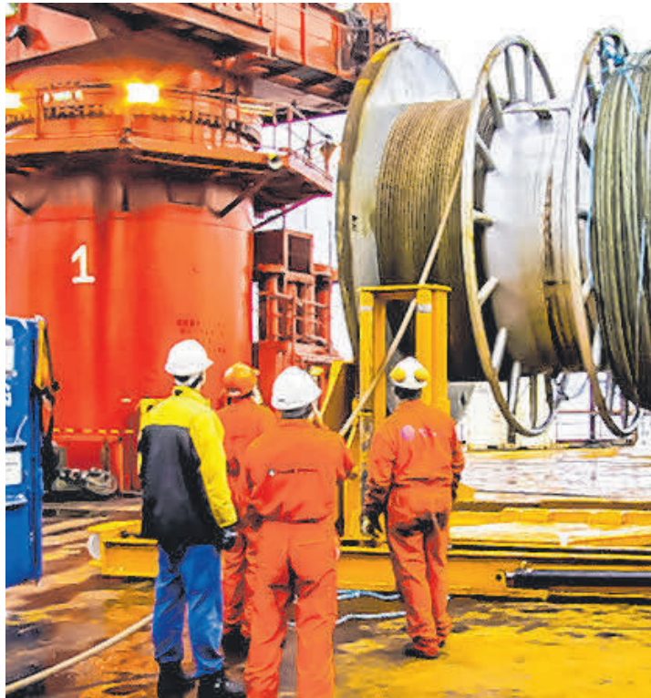
Steuerungen für Winden für die Verlegung von Kabeln auf dem Meeresgrund.
